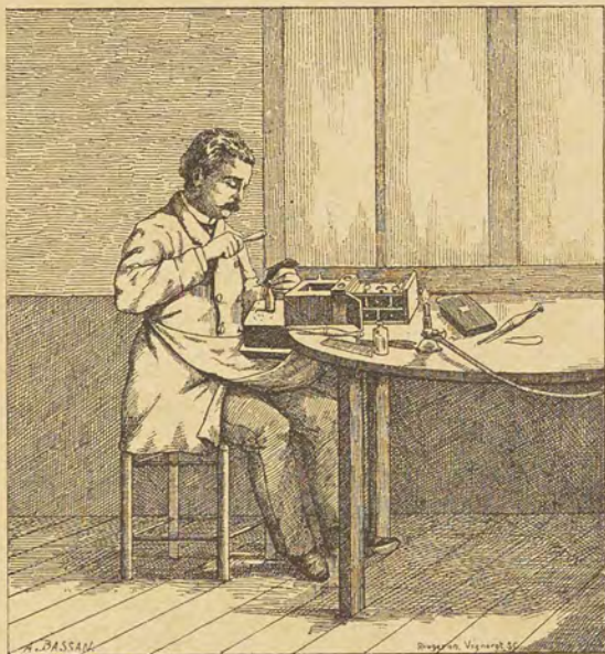
Fig. 31. — Clivage du diamant.
